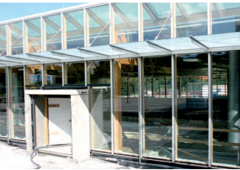
Während das Äußere der Halle steht, wird innen noch emsig gearbeitet. Foto: Berger
